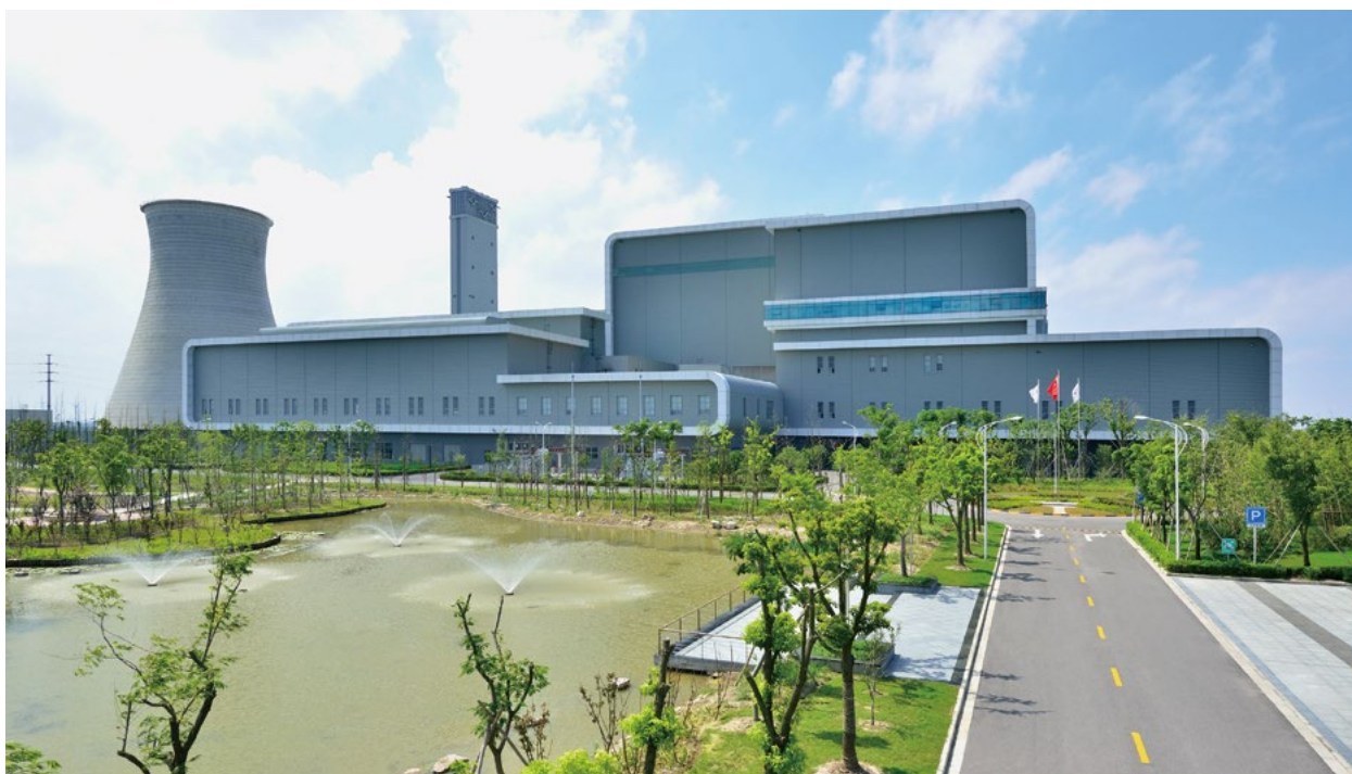
» 上海分行支持建设的上海老港再生能源利用中心
